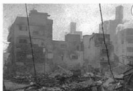
阪神・淡路大震災の焼死者の多くは、建物倒壊の下敷きで逃げ出せずに焼死している（撮影者：目黒公郎） 写真出典：東京直下大地震生き残り地図 旬報社
